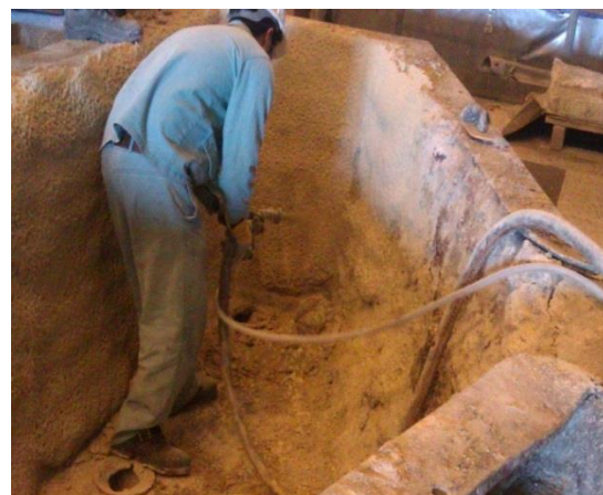
شکل ۴: ایستگاه کاری پلاسترزنی - بعد از مداخله
